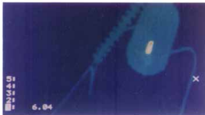
图 H39 阻波器内避雷器损坏
